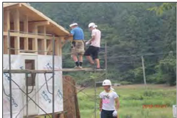
北海道ブックシェアリング寄贈のログハウス建設風景
